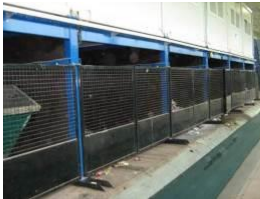
Слика 4.5.4-9. Предња страна боксева и транспортна трака за транспорт сортираног отпада ка балирки за секундарне сировине
