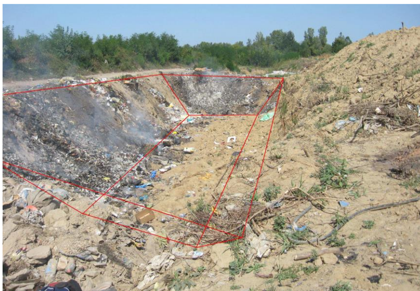
Слика 4.6.5-2. Изглед "касете" припремљене за одлагање отпада Извор: Елаборат санације одлагалишта отпада Лајковац, 2011 година.
