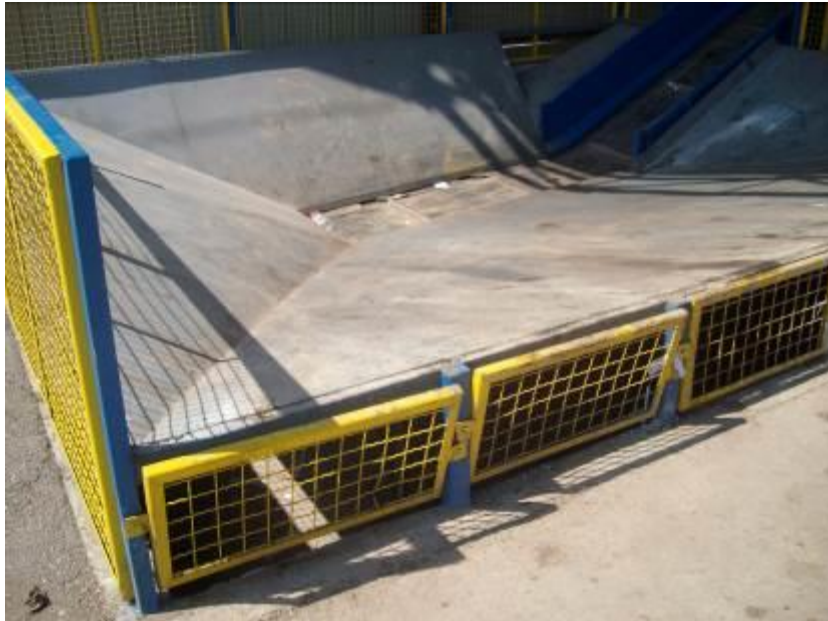
Слика 4.5.1-4. Усипни кош за рециклабилни материјал и прихватна трака на линији за одвајање отпада.
